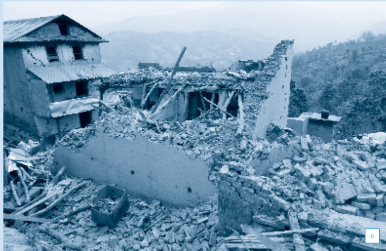
6 Die Bilder zeigen eindrücklich, dass die traditionelle Bautechnik (Holz und Stein im Verbund) bei allfälligen Erdbeben widerstandsfähiger ist. Fotos: © DEZA.
