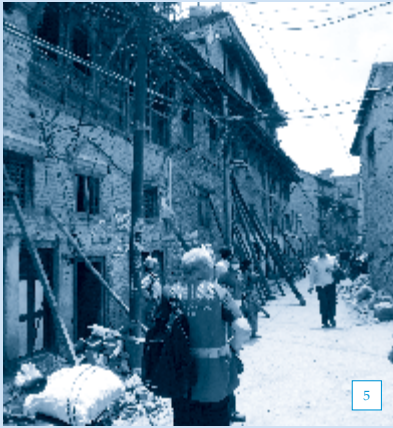
5 Stützen wurden als einfache Sofortmassnahme eingesetzt, um den Einsturz der Häuser zu verhindern. Foto: © DEZA.
