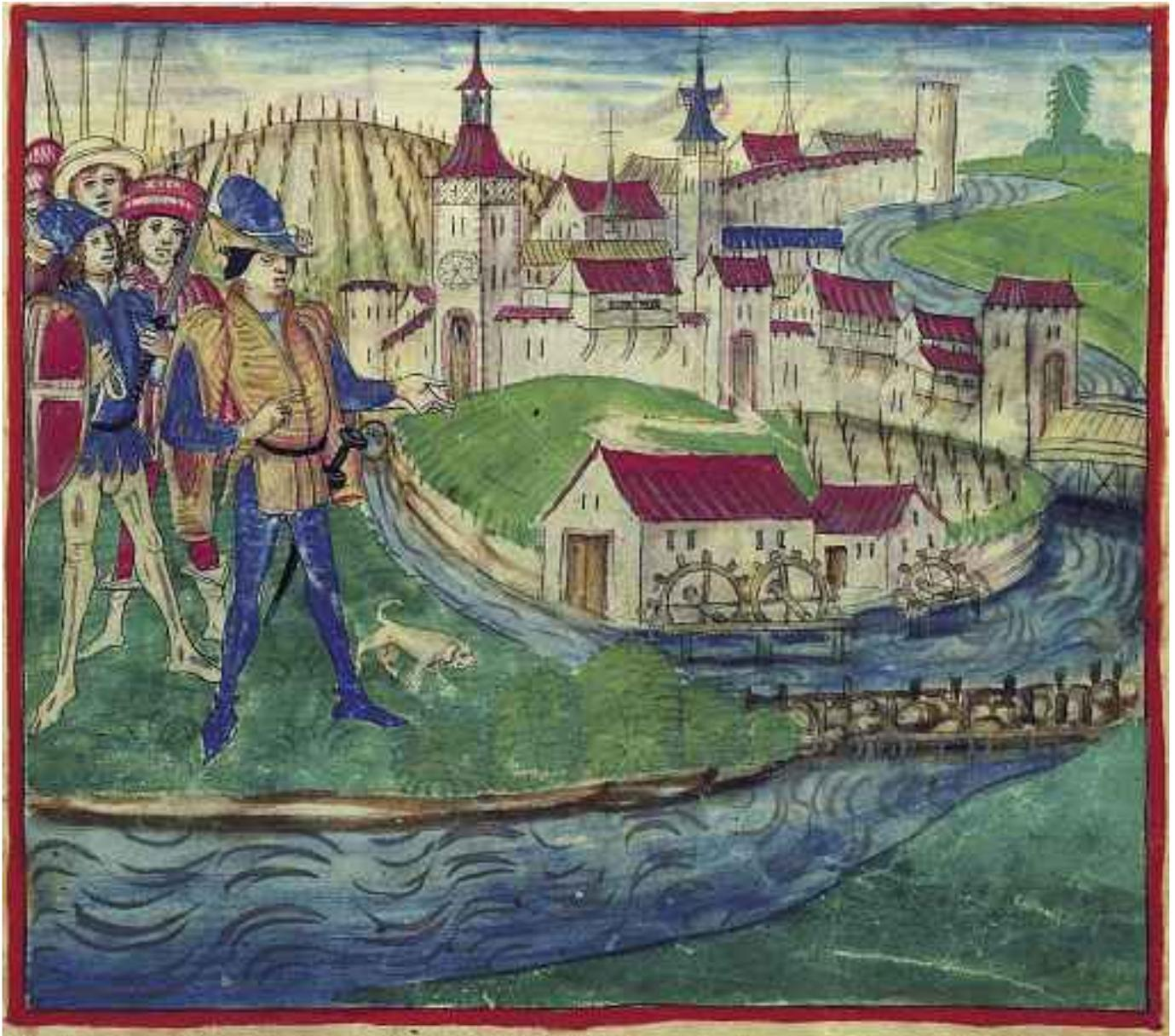
5 Die einzige mittelalterliche Abbildung der Mattenschwelle um 1483. Die Konstruktion bestand ursprünglich aus einer Reihe von in Blockbauweise gezimmerten und mit Steinen ausgefüllten Holzkästen, die auf der Sohle der Aare standen. Abbildung © Archäologischer Dienst des Kantons Bern.
