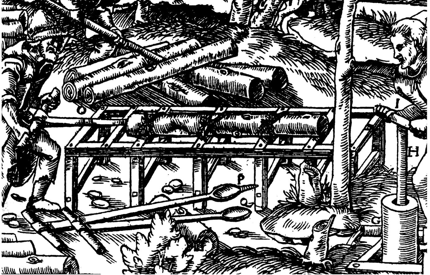
3 Das Teuchelbohren. Die Bohrungen ergaben Leitungsquerschnitte von 6 bis 10 cm. Holzschnitt aus Georg Agricola 1556 (Ausschnitt).
