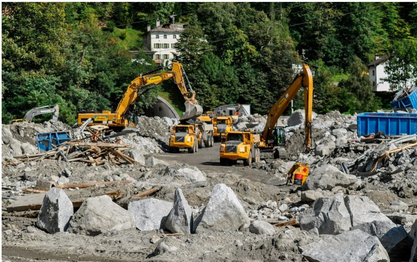
Des excavatrices spéciales sont utilisées dans le bassin de rétention plein à Bondo. En cas d'alarme, elles doivent être évacuées de la zone de danger en quatre minutes.
